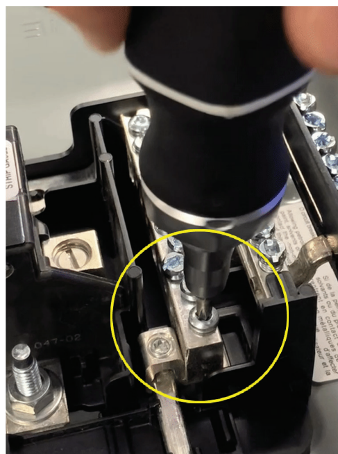
Figure 14 – Vérifier si le connecteur PoN droit bouge
