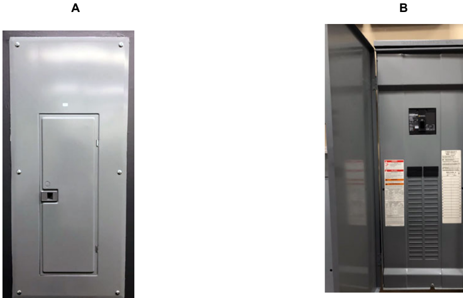
Figure 4 – Centres de charge intérieur et extérieur (exemples)
