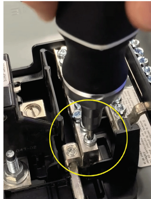
Figura 14 – Inspeccione el movimiento del conector PoN de la derecha
